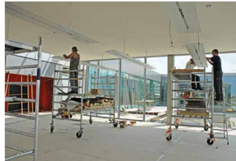
De 54 verlichtingsarmaturen verspreiden een diffuus licht op het plafond en een accentverlichting op de toonzaalinrichting
