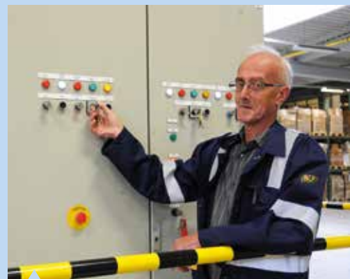
Jan bedient het stuurbord van het automatische magazijn.
