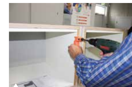
John maakt de nodige boringen met behulp van een boormal
