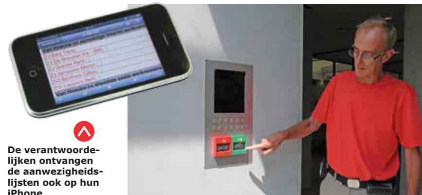
▲ Jan: "In geval van nood open je de deuren met toegangscontrole handmatig. Gebruik hiervoor de groene knoppen naast de deuren."
